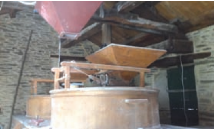
Rehabilitación dun muíño de auga
