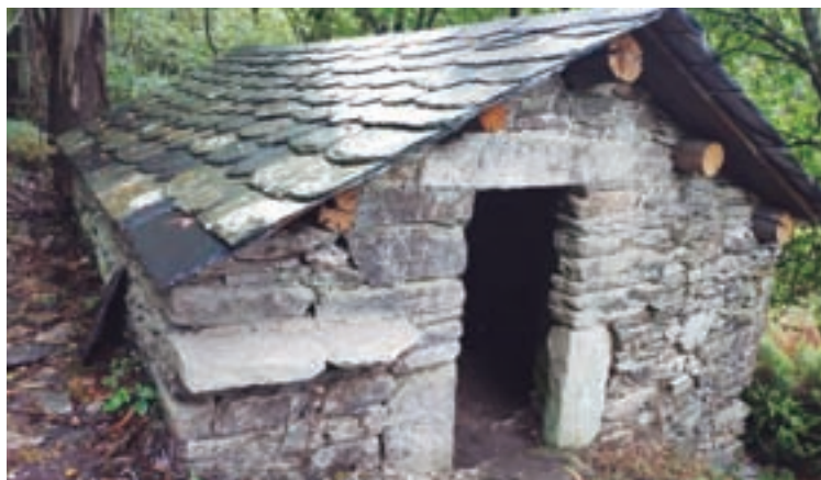
Estado dun dos batáns, trala finalización das obras
