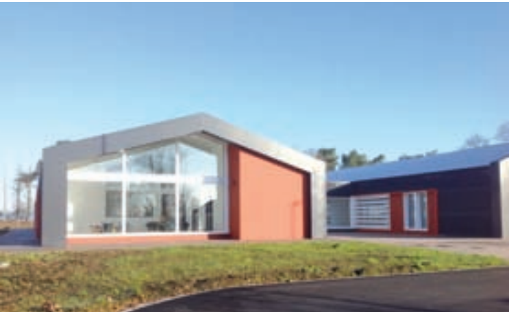
Centro para transtornos e patoloxías duais
