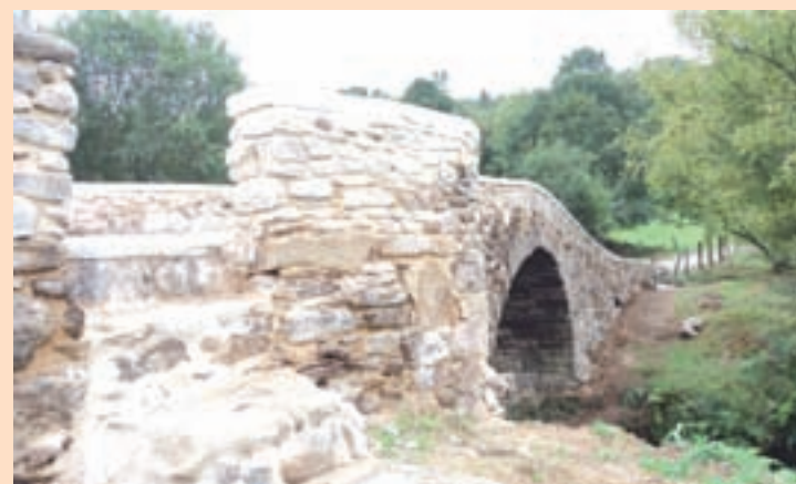
Estado da Ponte Bermuz, trala finalización das obras
