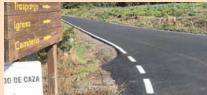
Unha imaxe da estrada, tras as obras de asfaltado
