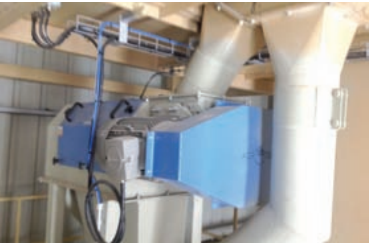
Adquisición de cernedor e a súa instalación
