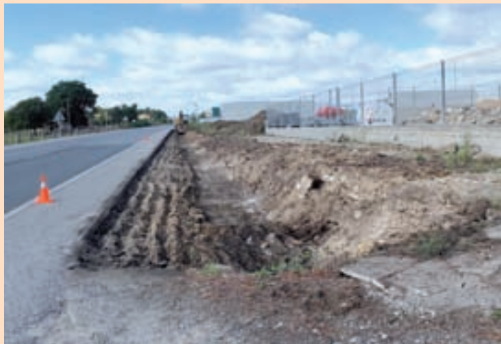
Unha instantánea das obras nos primeiros días
