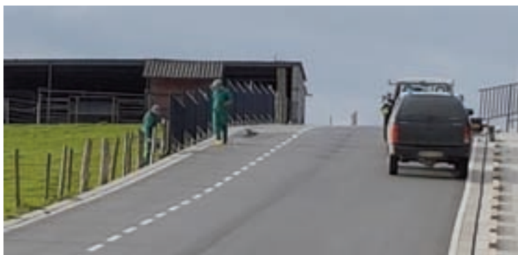
Operarios colocando a varanda na rúa
