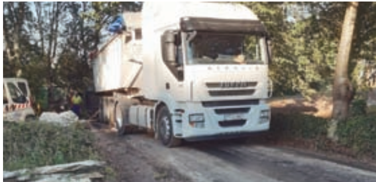
Obras en Rioaveso
