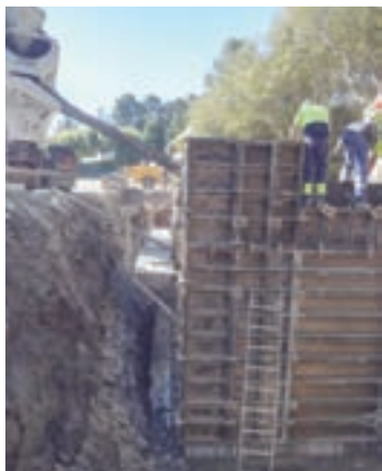
Obras en Espiñaredo
