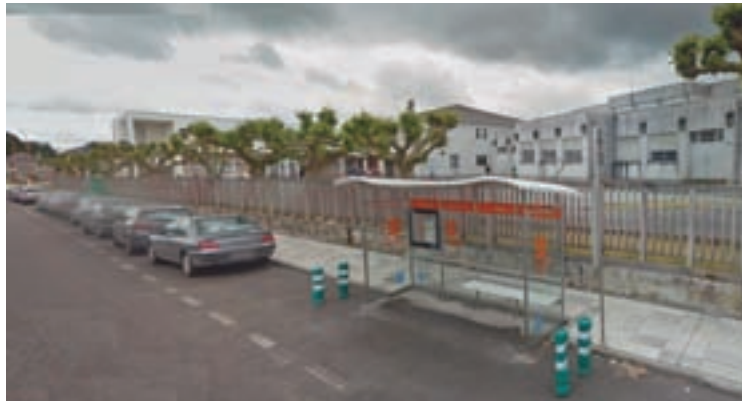
O CPI de Friol, onde se vai reparar a cuberta do polideportivo
