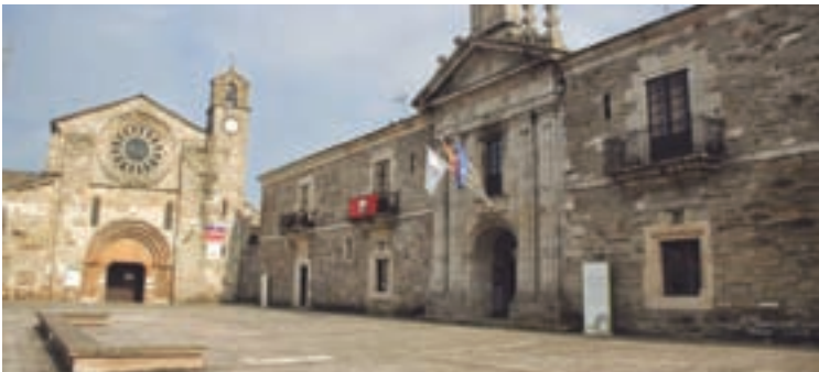
Fachada do Concello de Meira
