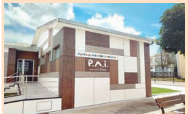
Unha vista do exterior do PAI de Friol
