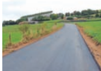
Estado da estrada tras as obras
