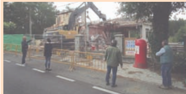
Unha imaxe do inicio das obras
