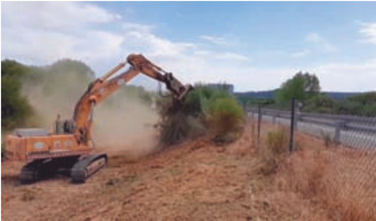
Labores de limpeza nunha estrada da provincia
