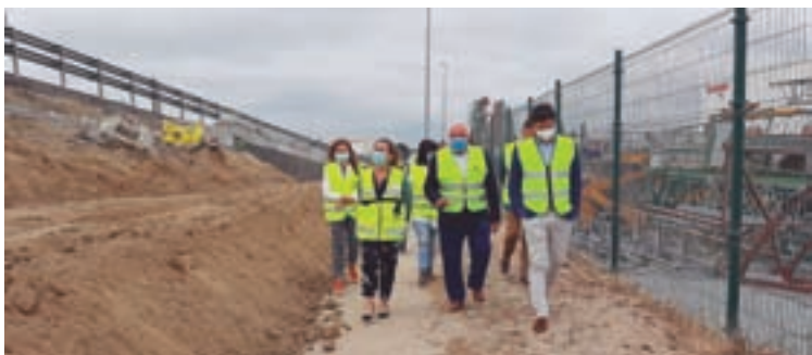
Visita da conselleira á zona de obra
