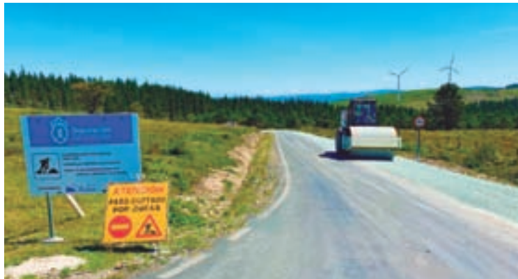
Traballos de ampliación na estrada do Freixo
