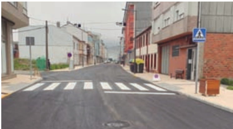
Estado no que quedou a avenida da Habana trala súa reparación
