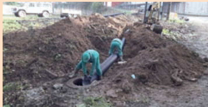
Imaxe dos traballos realizados na canalización en Bretoña
