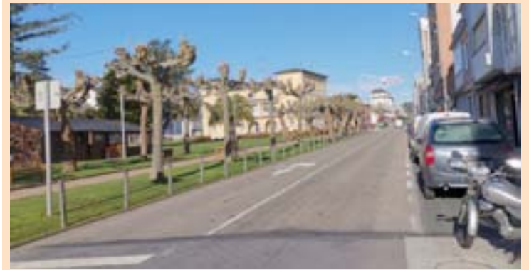
A avenida Ortigueira antes do comezo das obras
