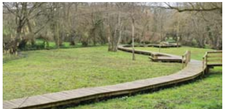
Estado no que quedou o paseo de Bretoña trala súa limpeza
