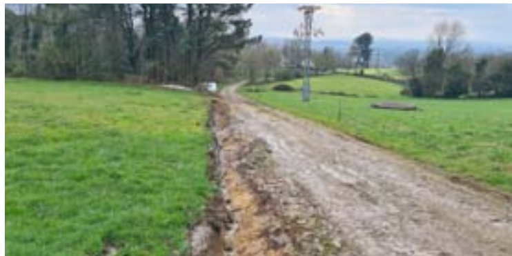
As obras do camiño de acceso ao depósito de Corvelle
