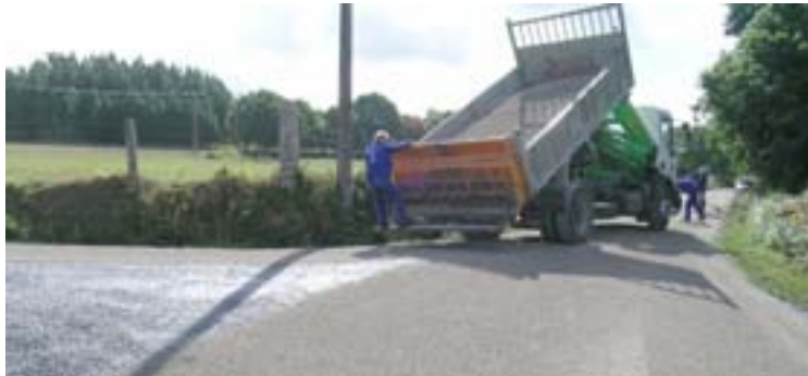
Operarios traballando nas obras das vías rurais de Friol
