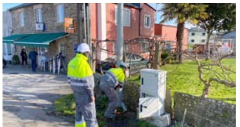
Instalación de luminarias en Baltar, Begonte
