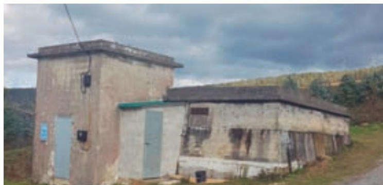
Depósito de auga de Grañanova
