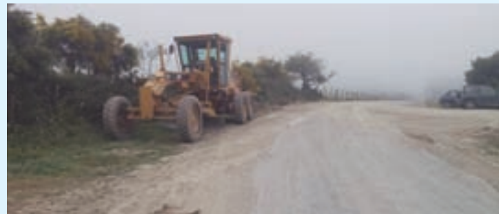
As obras na estrada
