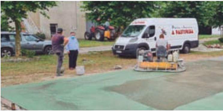
Finalización das obras da pista deportiva de Aguarda
