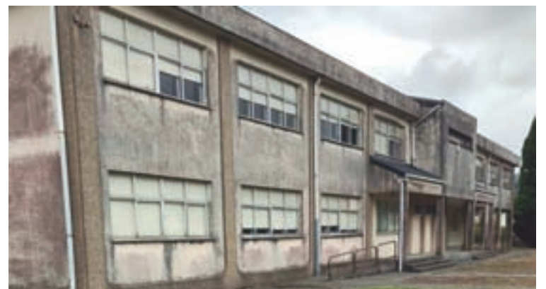
Imaxe actual do edificio onde se fará a residencia
