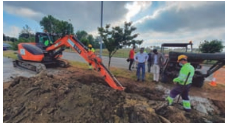
O alcalde, supervisando o inicio das obras
