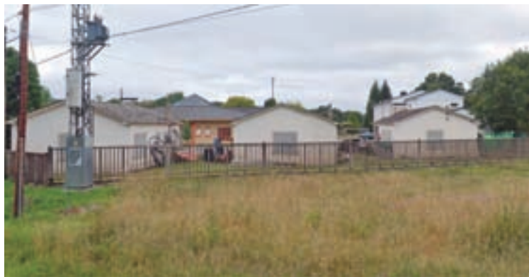
Os tres edificios xunto ao centro de saúde
