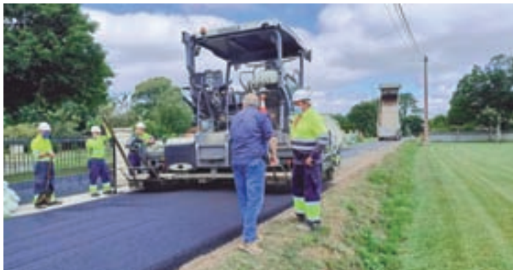
Un momento das obras en Uceira-Goiriz
