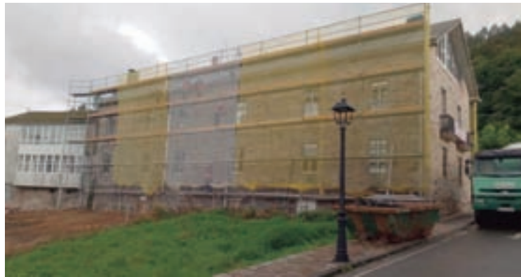
A casa consistorial de Muras, en obras
