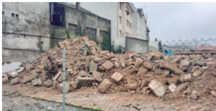
Estado no que quedou o solar tralo derrubamento da Casa da Botica
