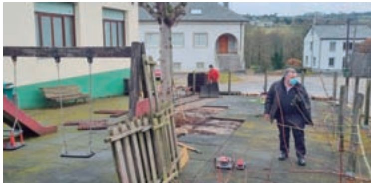
Obras no parque de Bretoña
